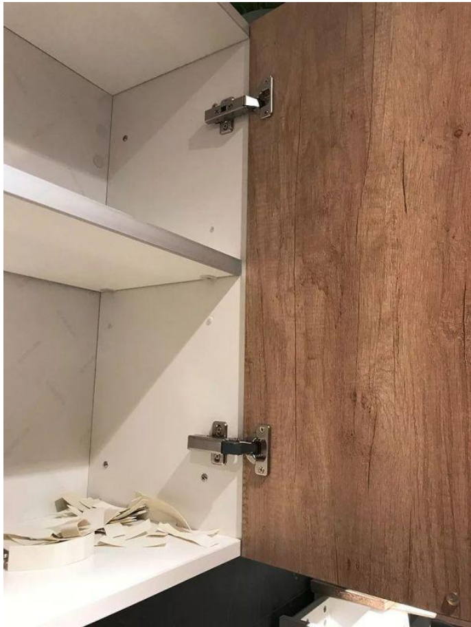
▲下边铰链加阻尼，上边铰链就没必要加了
